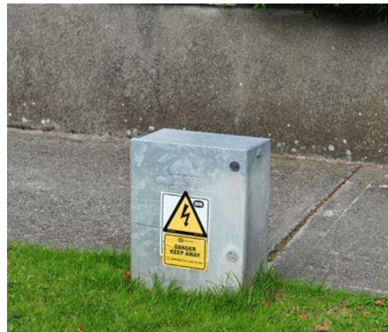
Figure 7-5 ESB Mini Pillar
